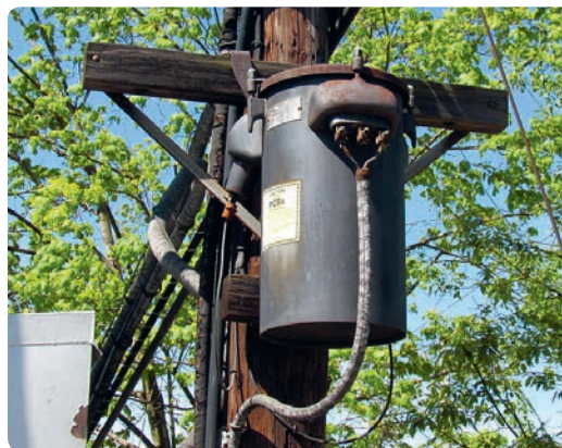
Stari transformatorji so glavni vir PCB.
