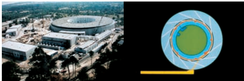
Slika 30.2 a) sinhrotron ELETTRA na Bazonvici pri Trstu med gradnjo b) shema obroča s pospeševalnimi celicami, magneti in merilnimi postajami
