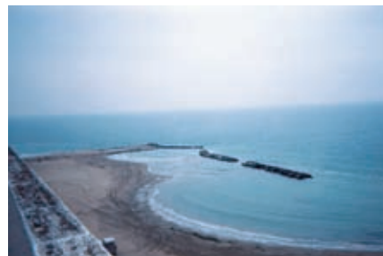
Slika 26.1 uklon morskih valov na porušnem pomolu
