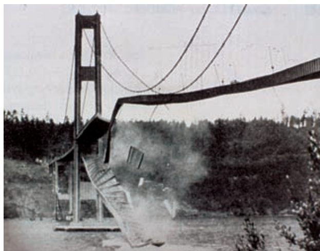
Slika 15.3 Štiri mesece po otvoritvi se je višje most Tacoma Narrows v ZDA zrušil v hudem vetru. Zaradi vrtincev je začelo cestišče sučno nihati okoli vzdolžne osi (leva slika). Nihanje se je "ujelo" z nastajanjem vrtincev, postajalo vse izrazitejše, dokler se cestišče ni zrušilo (desna slika). Pri novi konstrukciji so poskrbeli, da do tega ne more več priti.
