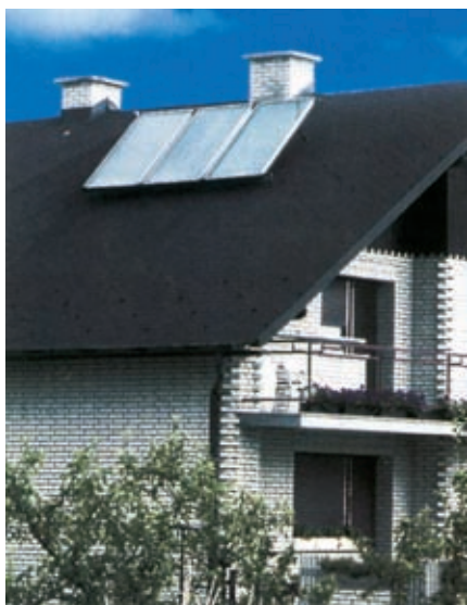
Slika 17.18 Sončna hiša – ogrevanje s kolektorji.
