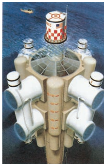
Slika 17.17 Oceanotermična elektrarna (OTE) ali toplotni stroj v tropskem morju. Zgornji del OTE oblika voda s temperaturo 25–30° C, spodnji del v globini do 1 km pa voda s temperaturo 4–8° C. Topla morska voda odda energijo delovnemu sredstvu. To izpari in njegova para poganja turbino. Na mestu, ki ga oblika mrzla voda, se delovno sredstvo spet utekočini.
